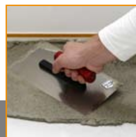
5. Gelijktijdig aanbrengen van mortel
