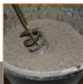
4. Mengen van de elastische mortel
