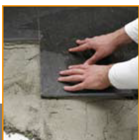
6. Tegels plaatsen (niet aankloppen)
